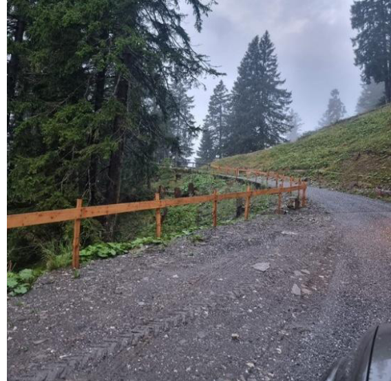
Abb.: Instandstellung und Ersatz diverser Zäune.
