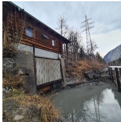
Abb.: Instandstellung der Kolmatierungsanlage, um die Bewässerung der Amphibienlaichgebiete von nationaler Bedeutung in Maienfeld sicherzustellen
