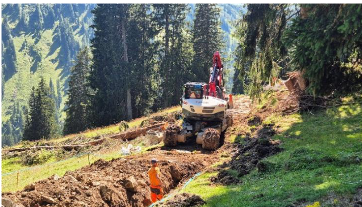
Abb.: Der Ausbau der Quellfassung mit den Zuleitungen und dem Druckreduzierventil trägt entscheidend zur langfristigen Gewährleistung der Betriebssicherheit der Alpen bei.
