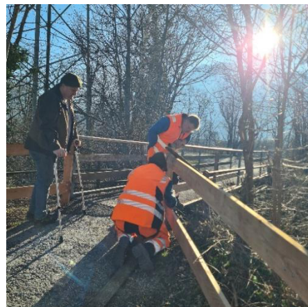
Abb.: Erneuerung des Brückengeländers beim Mühlbach in Fläsch
