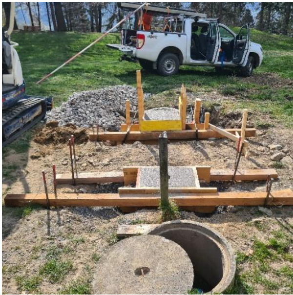
Abb.: Instandstellung des Weidebrunnen im Holz.
