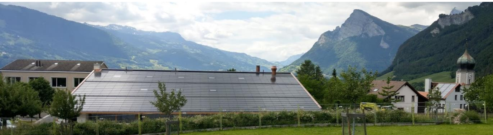
Um- und Neubau Mehrzweckgebäude Stand Mai 2020
