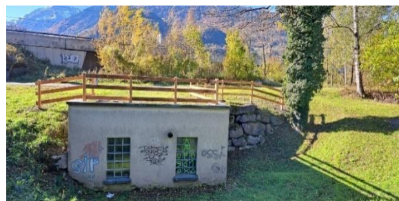
Abb.: Sicherheitszaun beim Pumpwerk Rieter.
