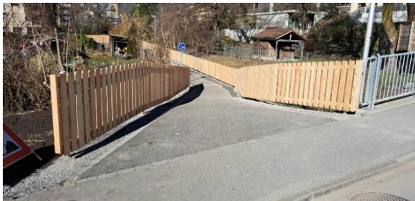
Abb.: Neuer Staketenzaun aus Eisenpfosten und Lärchenholz beim Mooshammerweg in Maienfeld.
