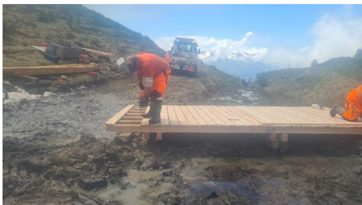
Abb.: Bauarbeiten an der neuen Brücke auf der Alp Nova.
