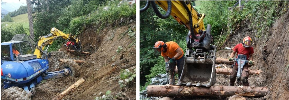
Abb.: Mittels Holzkasten wurde die Rutschung/Erosion an der talseitigen Böschung des Maienfeld der Ochsenbergwegs stabilisiert.
